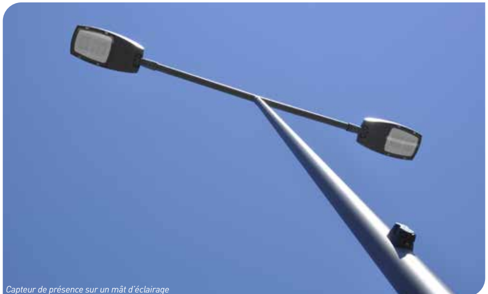
Capteur de présence sur un mât d'éclairage
