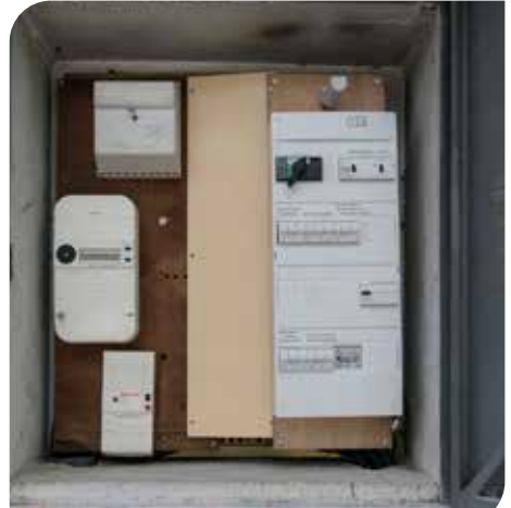
Armoire de commandes du SyDEV à Montaigu
