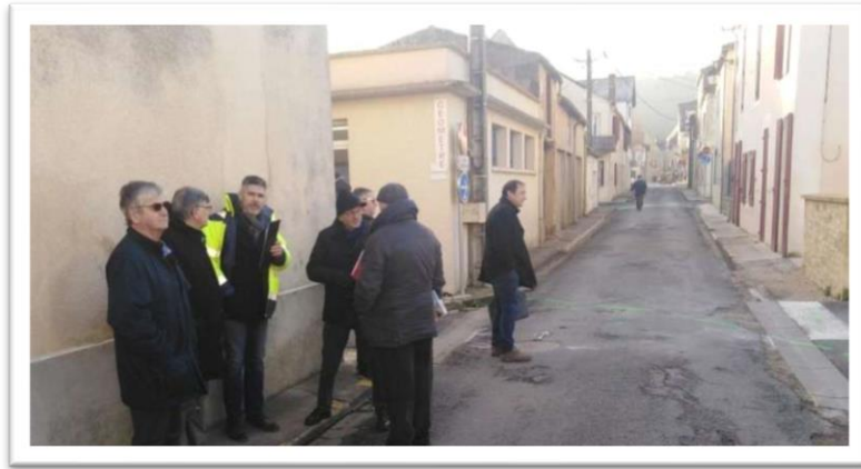
La première réunion de chantier s'est déroulée en présence des élus chargés des travaux et des techniciens.
