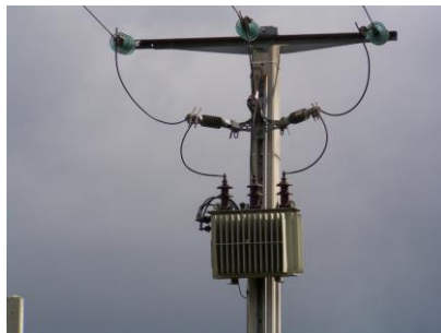
Poste sur poteau
