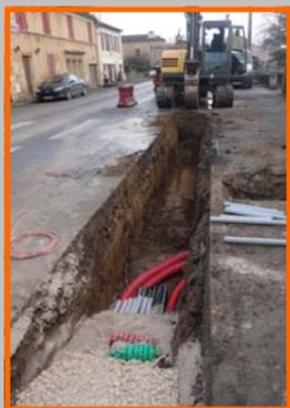
Phase 2 : déroulage, remblaiement et compactage
